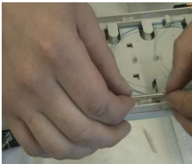
Рисунок 4.12– Укладка соединения в оптическую кассету
