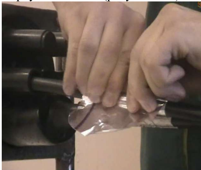
Рисунок 4.16–Защита кабеля алюминиевой фольгой
