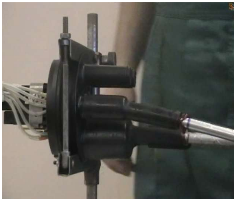
Рисунок 4.18– Красный клей на кабеле и крае трубки
