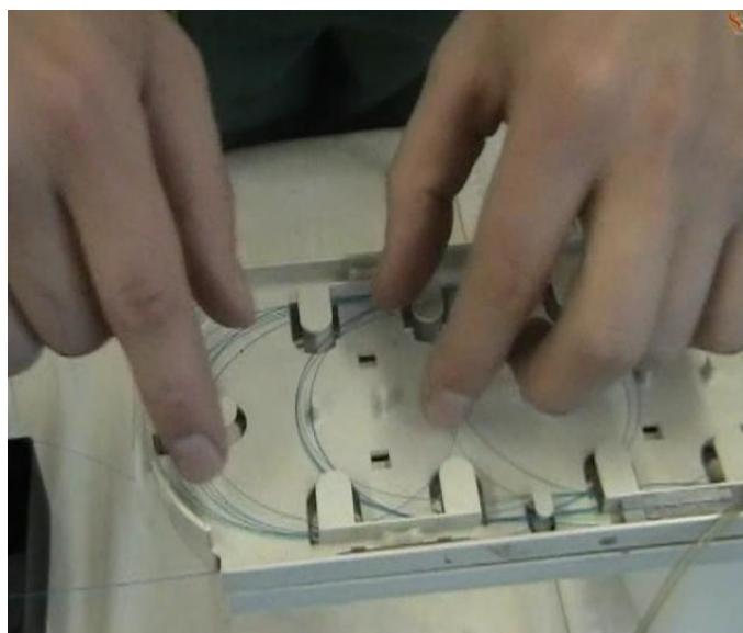
Рисунок 13 - Укладка волокна в сплайс-пластину
