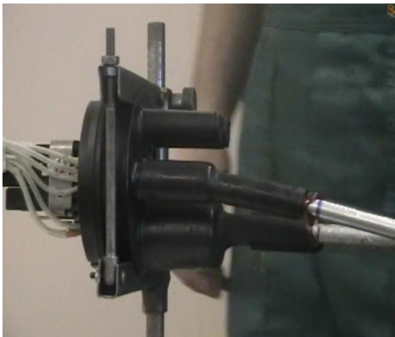
Рисунок 18 - Красный клей на кабеле и крае трубки
