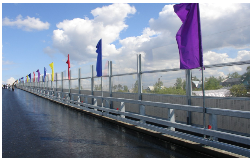
Рисунок 3 – Шумозащитный экран, установленный на Красносельском шоссе, г. Санкт-Петербург
