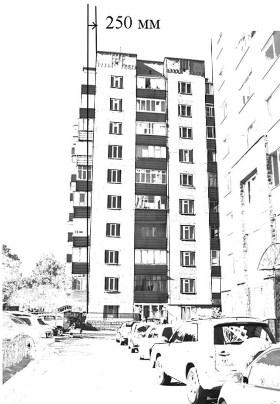
Рис. 7.2. Крен жилого дома по ул. Мирная в г. Курске
