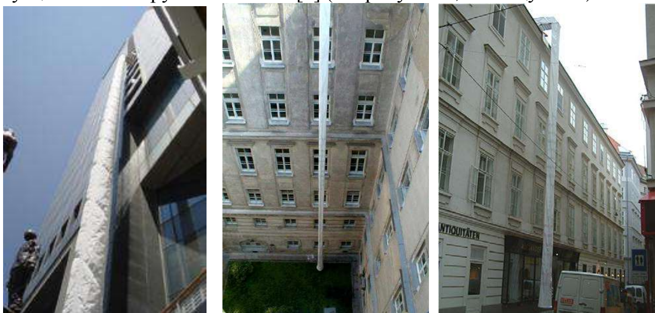
Рисунок 8 – Вертикальный спиральный спасательный рукав (жёлоб) EUROACE S-1
