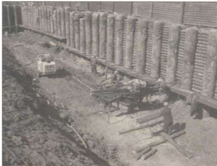
Рисунок 1. Устройство грунтовых анкеров
