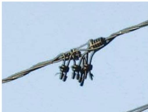
В целом задача выполнена: ВЛИ прочно соединена в пролете по несущей нейтрали, которая несет на себе всю механическую нагрузку, одноименные фазные провода и провод нейтрали электрически соединены между собой, и места соединений - герметичны.
