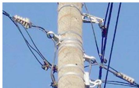
Еще интересный момент: концы несущего провода с тыльных концов анкерных зажимов заведены в кольца анкерных кронштейнов СА 1500. Решение спорное: при ветровых нагрузках есть опасность перетирания изоляции на нейтральных проводах в местах соприкосновения их с кронштейнами. Это может привести к нарушению изолированности системы.
