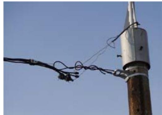
На первый взгляд, это решение очень неожиданное. Но, если присмотреться, оно даже логичное: на концевой опоре каждый из четырех проводов жгута СИП закреплен на своем стеклянном изоляторе. И зачем тогда нужна какая-то там арматура для СИП, когда есть проверенные стеклянные изоляторы?
