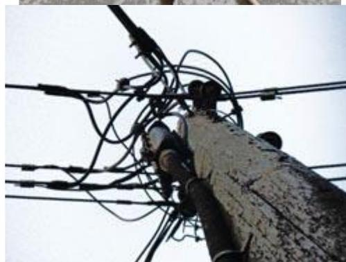
Концы СИП подключаются к голым проводам с помощью плашечных ответвительных зажимов.
