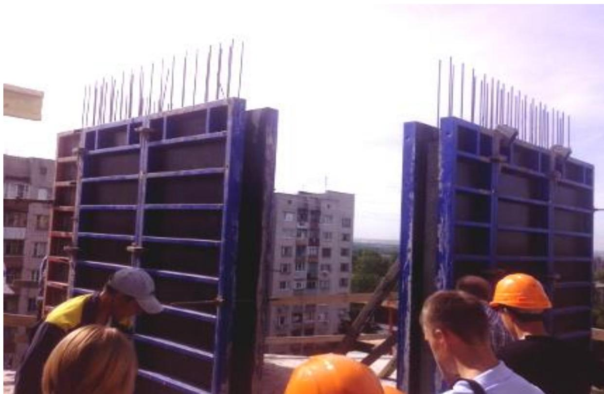
Крупнощитовая опалубка применяется для бетонирования крупных элементов здания, таких как протяжные стены, перекрытия и т.д.
