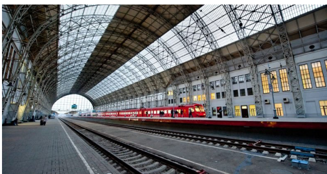
Обследование здания Киевского вокзала, г. Москва, 2018 г.
