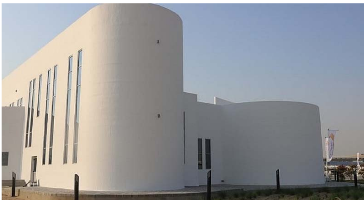
Рис. 5. Самое крупное в мире здание, напечатанное при помощи 3D-принтера. Дубай. Фото: а pis-cor.com 2
