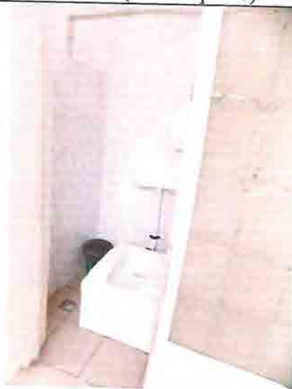
Фото № 203 Санузел мужской 3 этаж (левое крыло)
