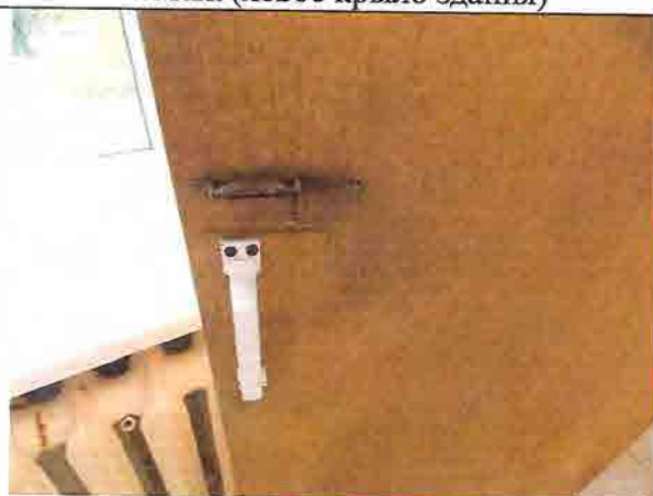
Фото № 192 Санузел женский 4 этаж (левое крыло здания)
