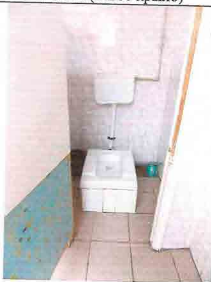
Фото № 202 Санузел мужской 3 этаж (левое крыло)
