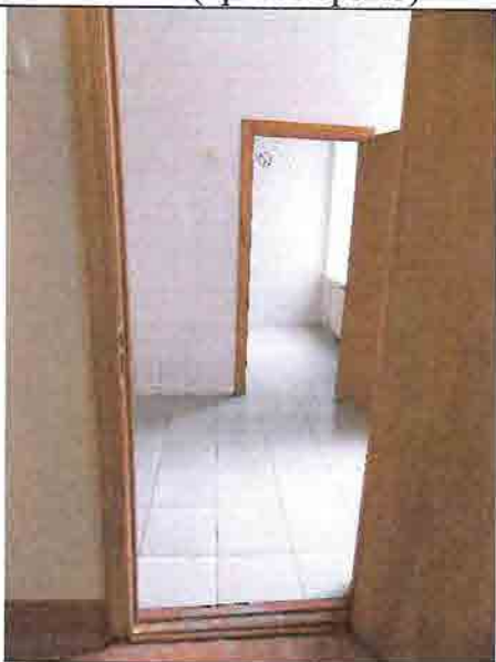
Фото № 230 Мужской санузел 1 этаж (правое крыло)
