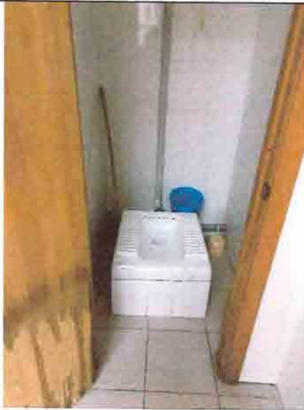
Фото № 216 Женский санузел 2 этаж (левое крыло)
