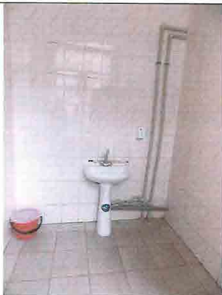
Фото № 232 Мужской санузел 1 этаж (правое крыло)
