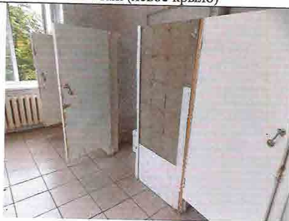
Фото № 201 Санузел мужской 3 этаж (левое крыло)
