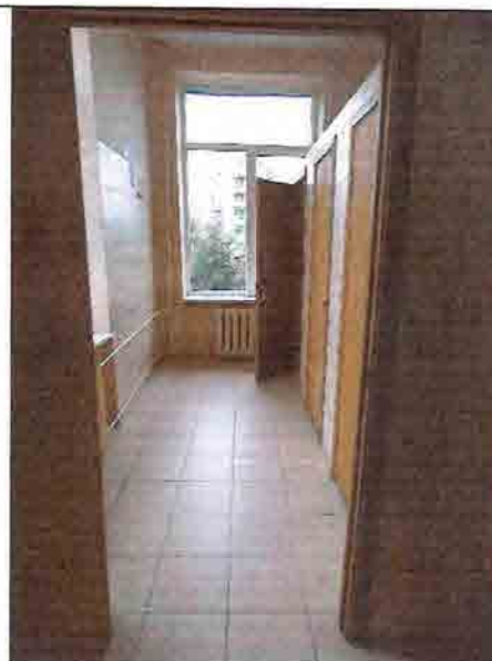
Фото № 187 Санузел женский 4 этаж (левое крыло здания)
