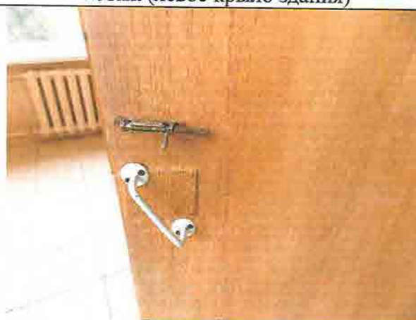
Фото № 189 Санузел женский 4 этаж (левое крыло здания)
