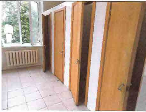
Фото № 214 Женский санузел 2 этаж (левое крыло)
