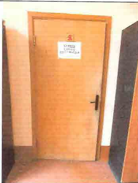
Фото № 180 Санузел женский 4 этаж (левое крыло здания)
