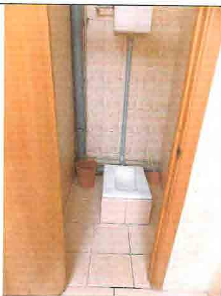
Фото № 188 Санузел женский 4 этаж (левое крыло здания)
