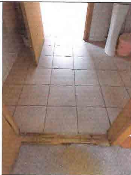
Фото № 210 Женский санузел 2 этаж (левое крыло)
