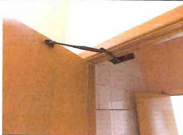
Фото № 196 Санузел мужской 3 этаж (левое крыло)
