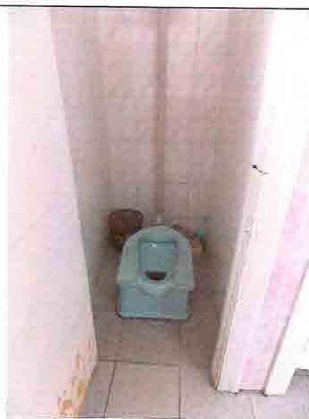
Фото № 227 Женский санузел 1 этаж (левое крыло здания)
