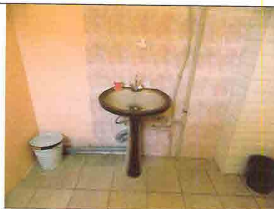
Фото № 223 Женский санузел 1 этаж (левое крыло здания)
