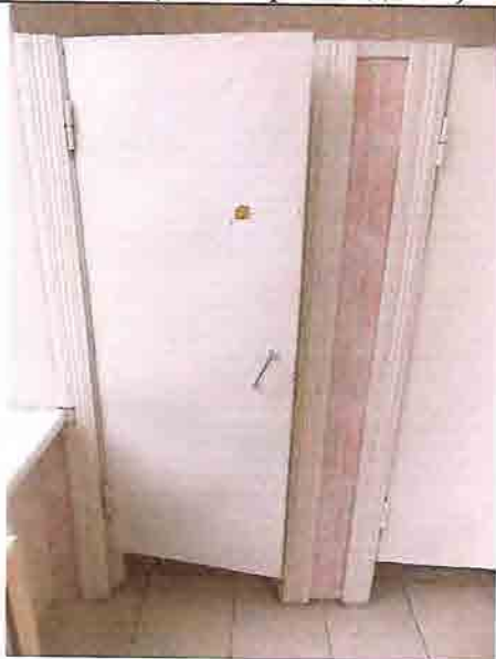
Фото № 226 Женский санузел 1 этаж (левое крыло здания)
