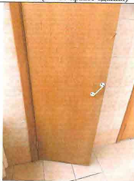
Фото № 193 Санузел женский 4 этаж (левое крыло здания)
