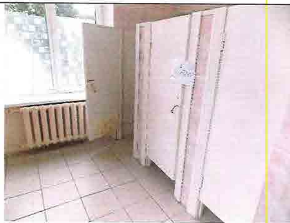
Фото № 225 Женский санузел 1 этаж (левое крыло здания)
