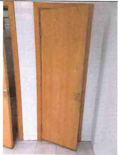
Фото № 215 Женский санузел 2 этаж (левое крыло)
