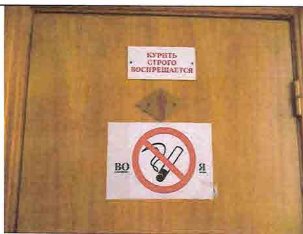
Фото № 229 Мужской санузел 1 этаж (правое крыло)
