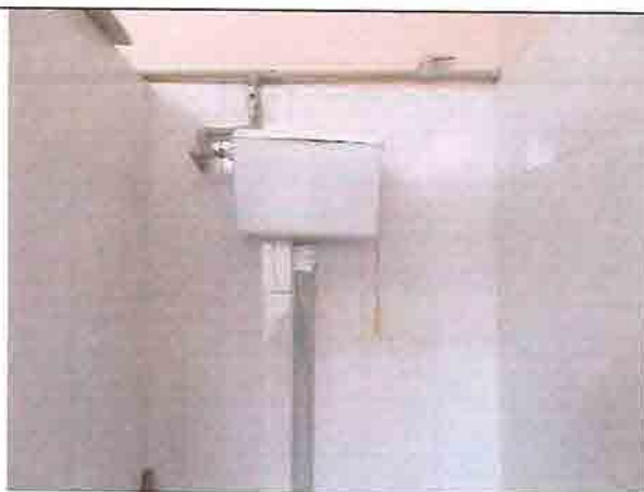
Фото № 218 Женский санузел 2 этаж (левое крыло)
