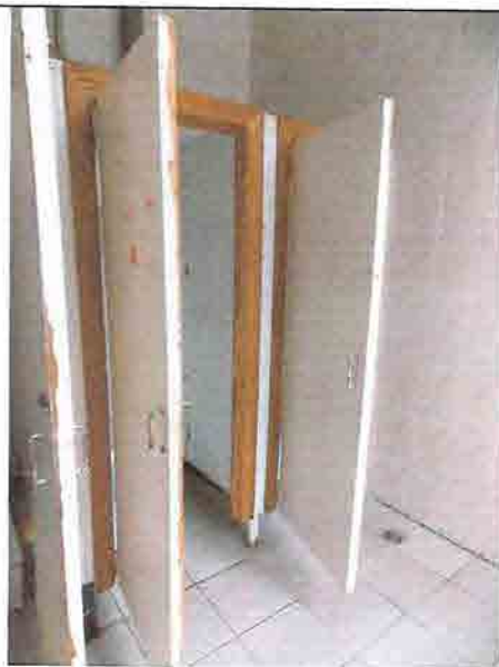
Фото № 236 Мужской санузел 1 этаж (правое крыло)
