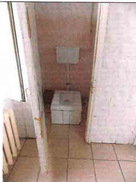
Фото № 205 Санузел мужской 3 этаж (левое крыло)
