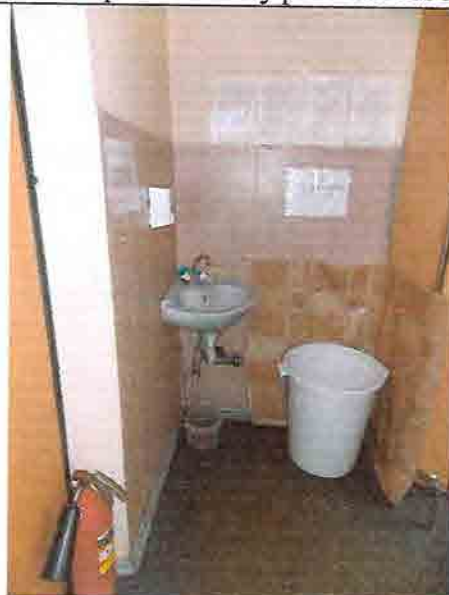
Фото № 134 Умывальная зона в буфете на 1-м этаже
