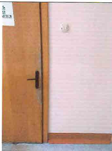
Фото № 211 Женский санузел 2 этаж (левое крыло)
