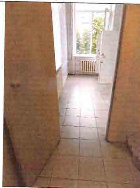
Фото № 199 Санузел мужской 3 этаж (левое крыло)
