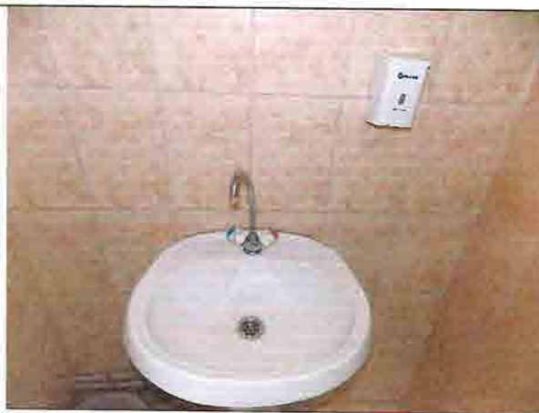
Фото № 186 Санузел женский 4 этаж (левое крыло здания)
