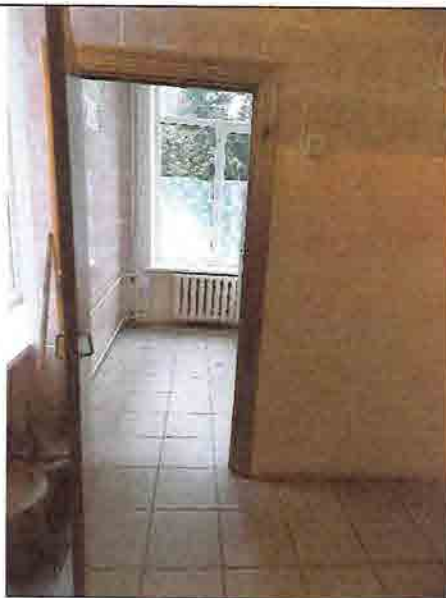
Фото № 224 Женский санузел 1 этаж (левое крыло здания)
