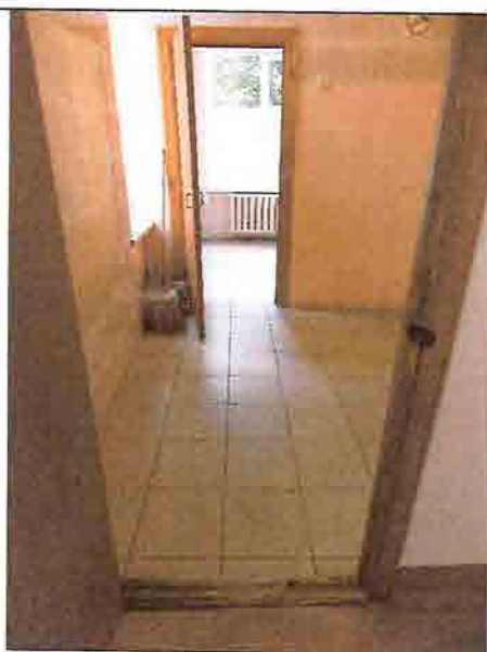
Фото № 220 Женский санузел 1 этаж (левое крыло здания)
