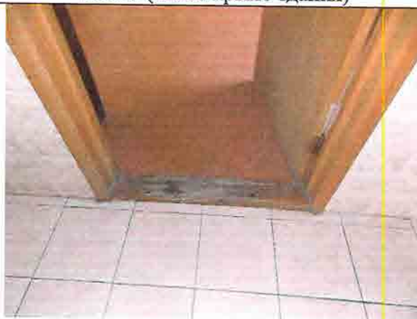
Фото № 183 Санузел женский 4 этаж (левое крыло здания)
