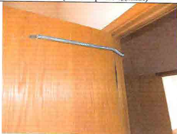
Фото № 182 Санузел женский 4 этаж (левое крыло здания)
