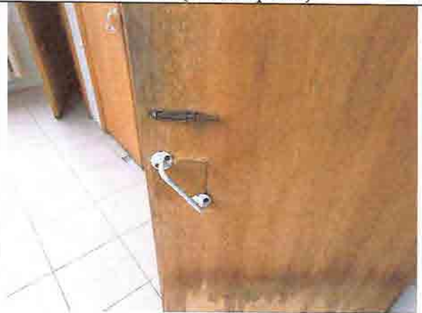
Фото № 217 Женский санузел 2 этаж (левое крыло)
