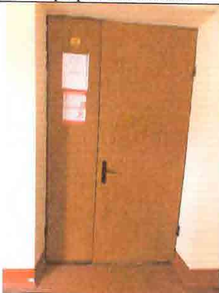
Фото № 128 Входная дверь в буфет на 1-м этаже
