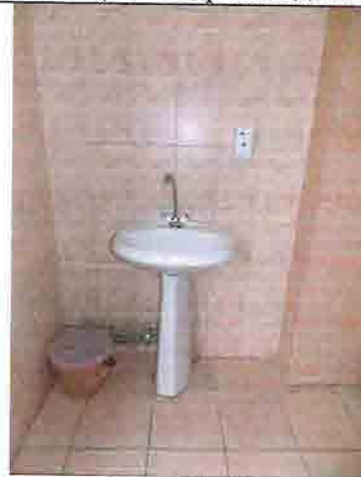
Фото № 185 Санузел женский 4 этаж (левое крыло здания)
