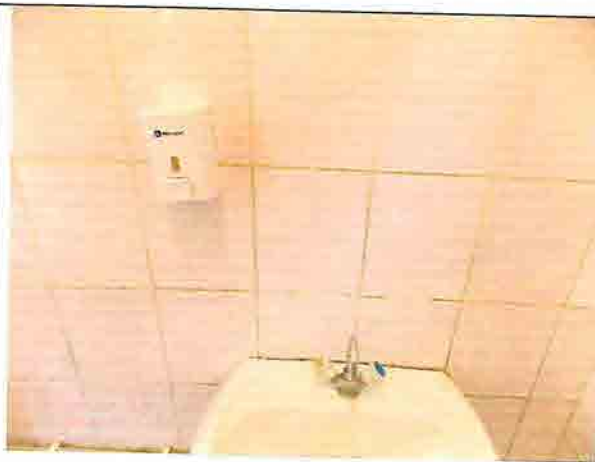
Фото № 198 Санузел мужской 3 этаж (левое крыло)
