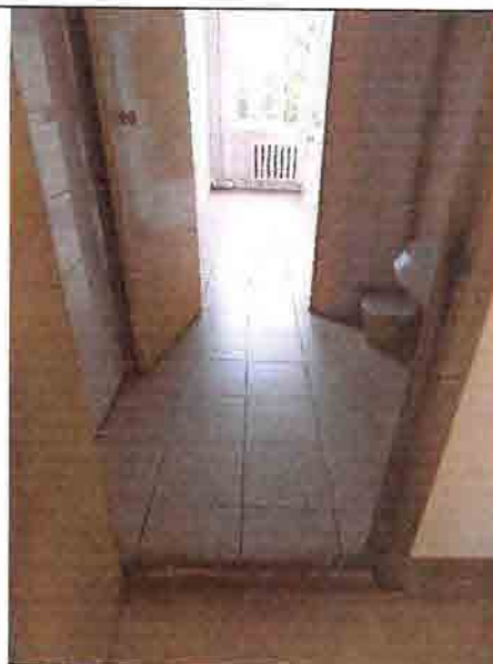
Фото № 195 Санузел мужской 3 этаж (левое крыло)
