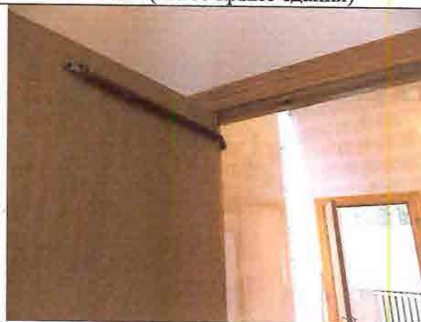
Фото № 221 Женский санузел 1 этаж (левое крыло здания)
