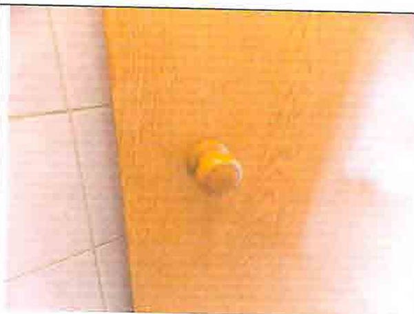
Фото № 200 Санузел мужской 3 этаж (левое крыло)
