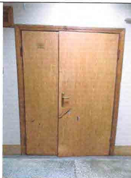
Фото № 151 Аудитория № 02 (цокольный этаж)
