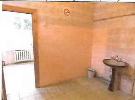
Фото № 222 Женский санузел 1 этаж (левое крыло здания) Умывальная комната
