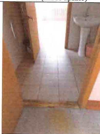
Фото № 209 Женский санузел 2 этаж (левое крыло)
