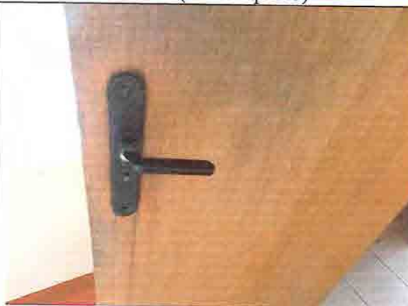
Фото № 208 Женский санузел 2 этаж (левое крыло)
