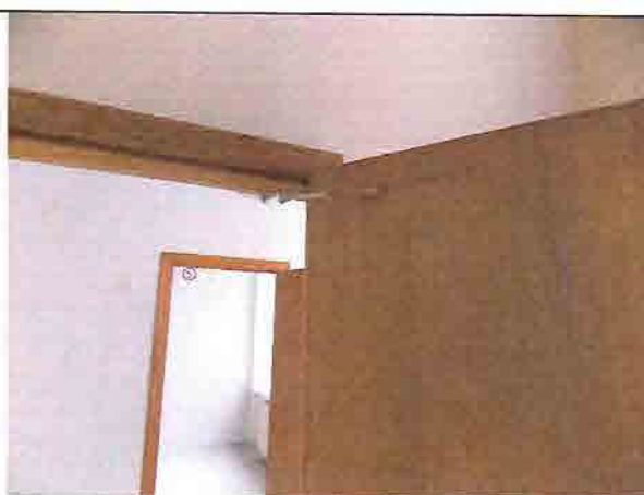
Фото № 231 Мужской санузел 1 этаж (правое крыло)
