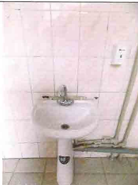
Фото № 233 Мужской санузел 1 этаж (правое крыло)
