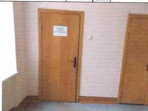
Фото № 206 Санузел мужской 3 этаж (левое крыло)
