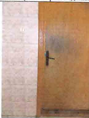
Фото № 184 Санузел женский 4 этаж (левое крыло здания)
