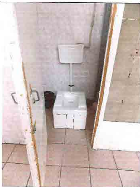
Фото № 204 Санузел мужской 3 этаж (левое крыло)
