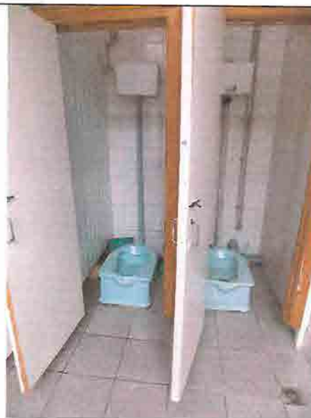
Фото № 237 Мужской санузел 1 этаж (правое крыло)
