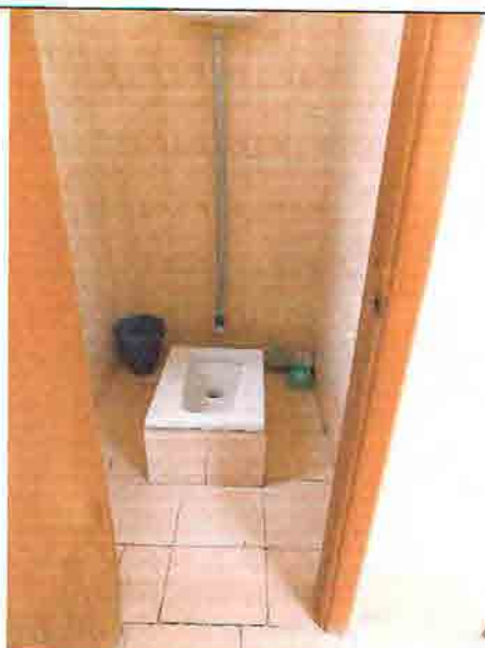
Фото № 190 Санузел женский 4 этаж (левое крыло здания)
