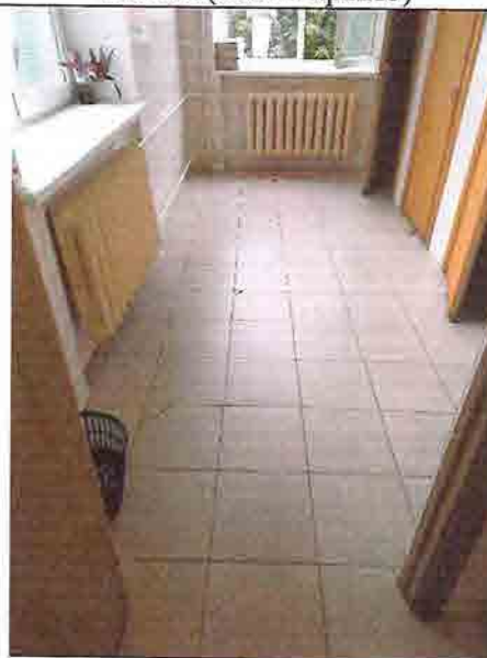
Фото № 213 Женский санузел 2 этаж (левое крыло)
