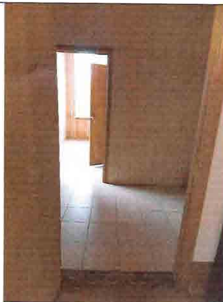
Фото № 181 Санузел женский 4 этаж (левое крыло здания)
