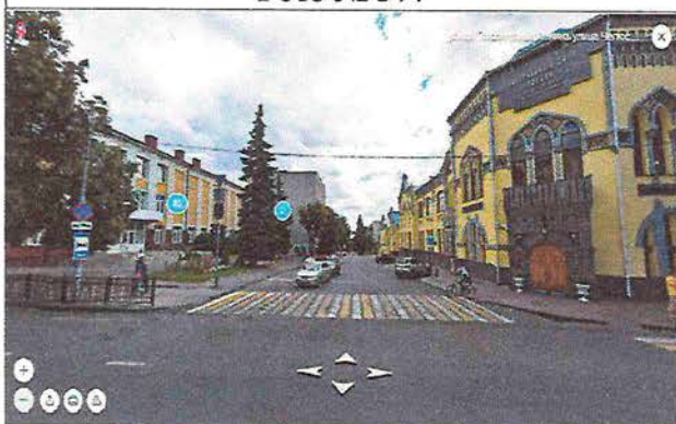
Фото № 379 Пешеходный переход ул. Челюскинцев
