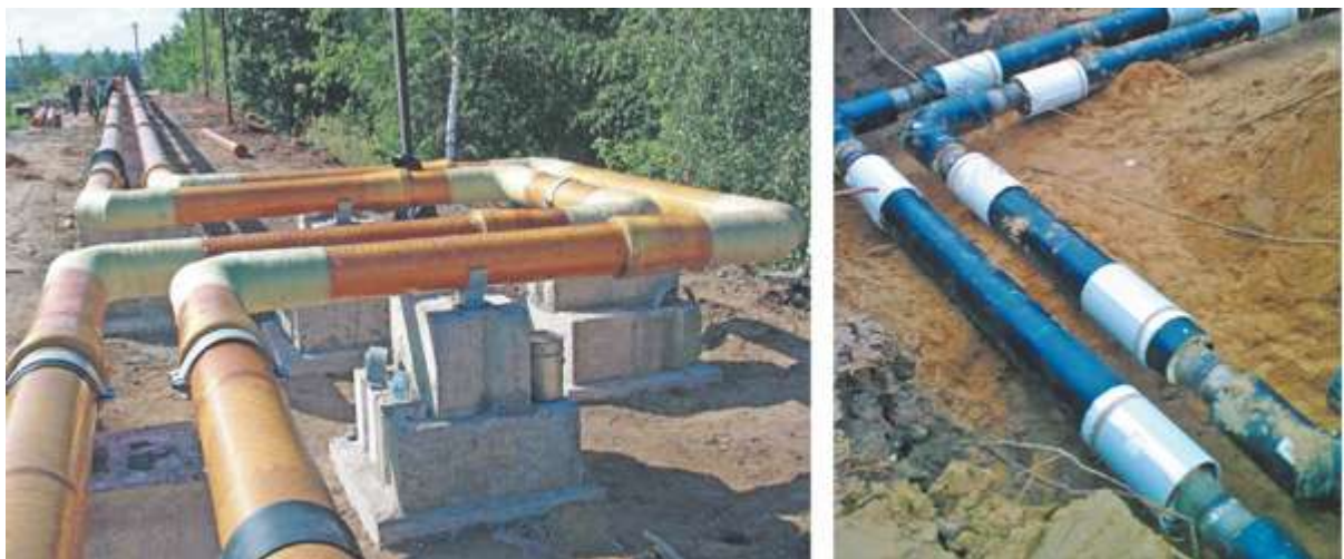
Рис.8 – П-образные компенсаторы
