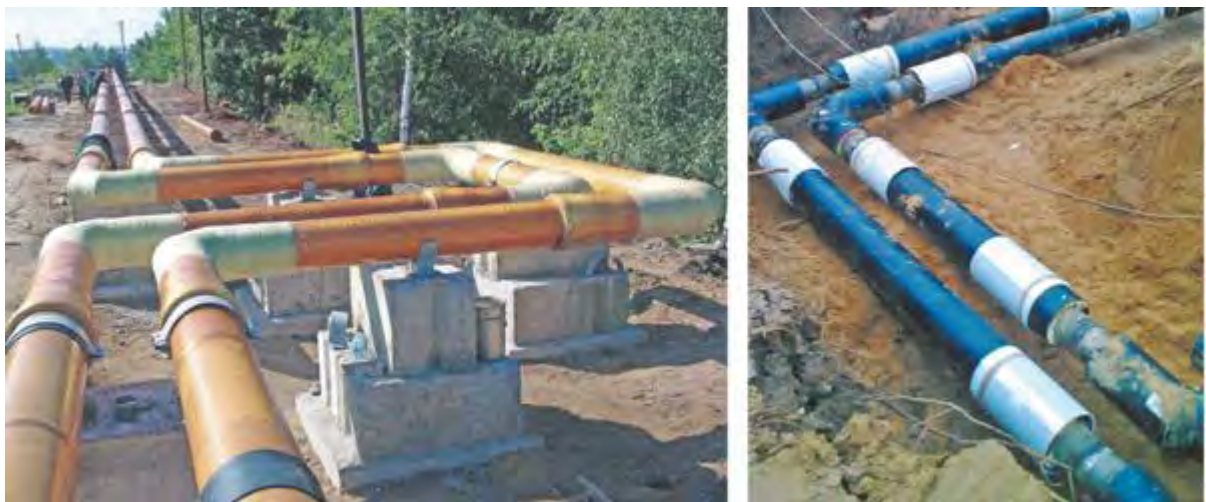
Рис.8 – П-образные компенсаторы
