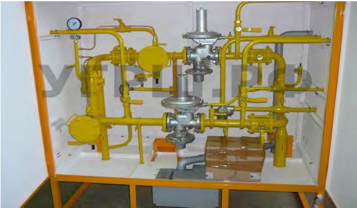
Рис. 25 - ГРПШ с двумя регуляторами РДК-50Н, с утепленным корпусом жидкой теплоизоляцией "Корунд" и газовым обогревателем.
