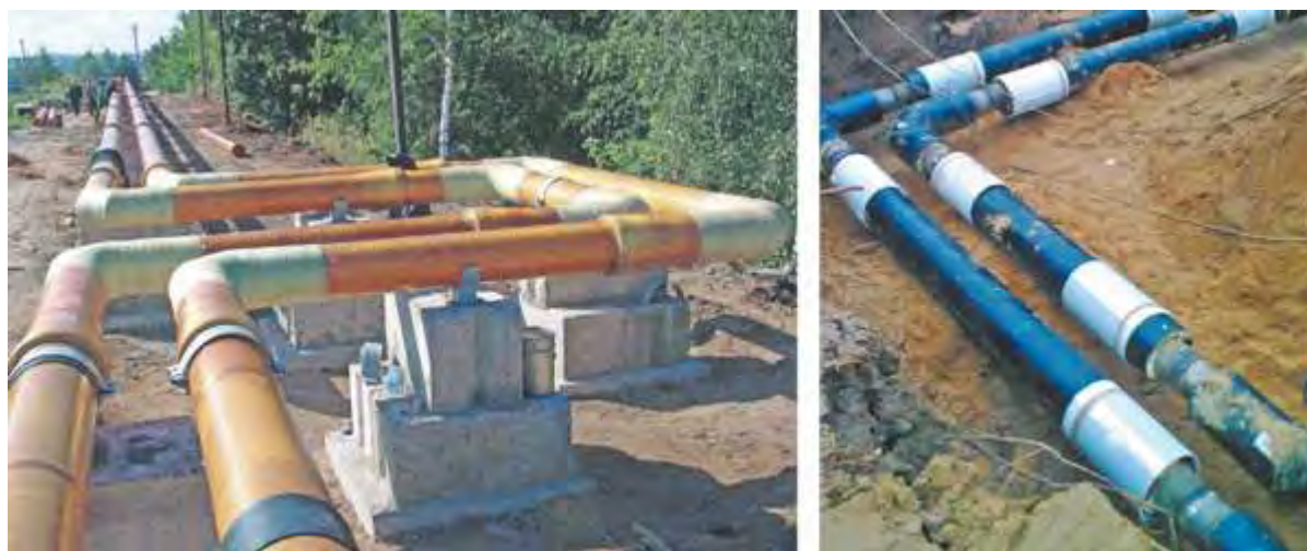
Рис.8 – П-образные компенсаторы
