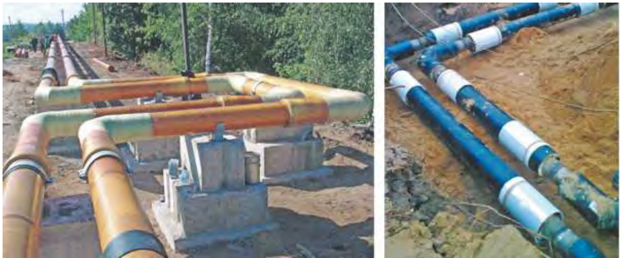
Рис.8 – П-образные компенсаторы
