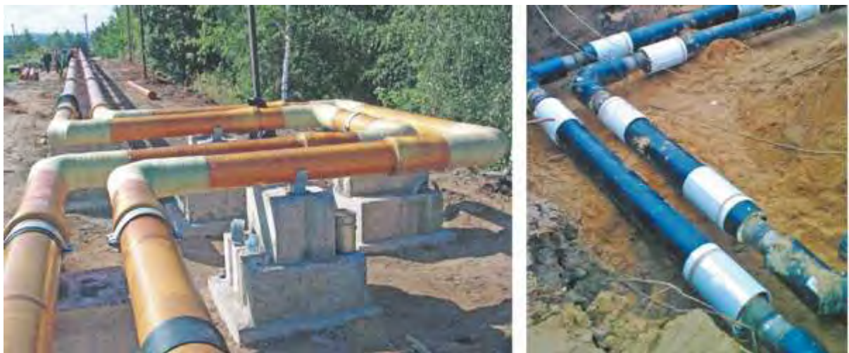
Рис.8 – П-образные компенсаторы
