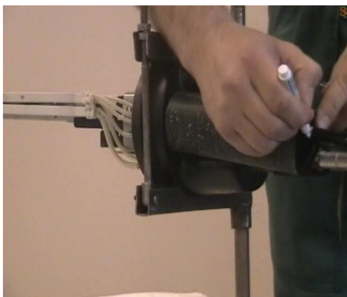
Рисунок 15 - Отметка длины трубки на внешней оболочке кабеля
