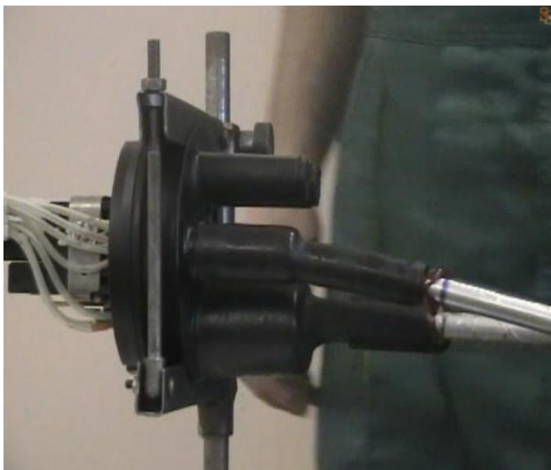
Рисунок 18 - Красный клей на кабеле и крае трубки
