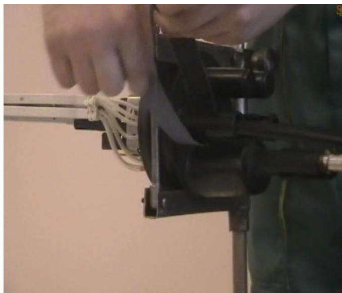
Рисунок 14 - Обработка кабельного ввода
