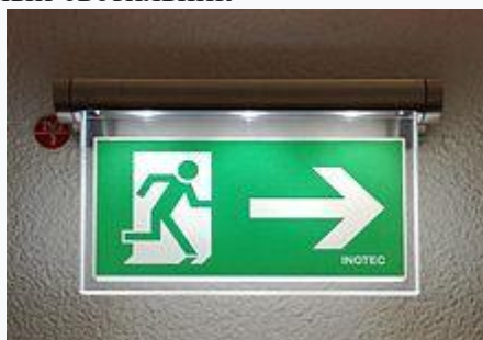
светодиодный указатель эвакуационного выхода
