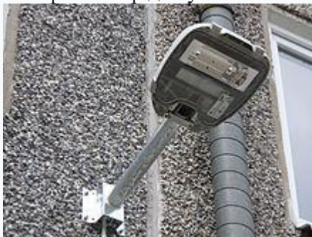
Освещение двора многоквартирного дома светодиодным консольным светильником
