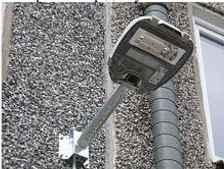
Освещение двора [многоквартирного дома](#) светодиодным консольным светильником
